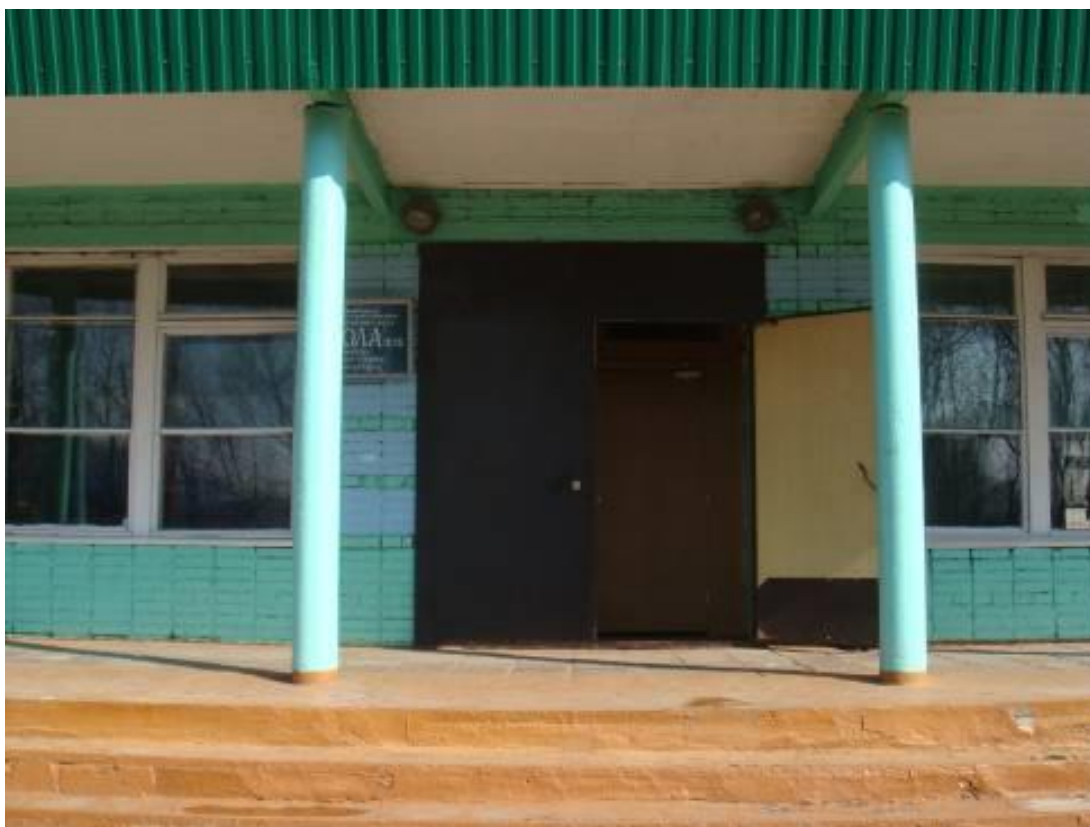
Фото 4 - вход в здание
